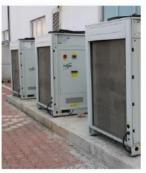
İklimlendirme için 3 x 50 kW Isı Pompası İşletmede doğalgaz kullanımından kaynaklı 118,44 ton CO<sub>2</sub>-e emisyonunun önüne geçilmiştir.
